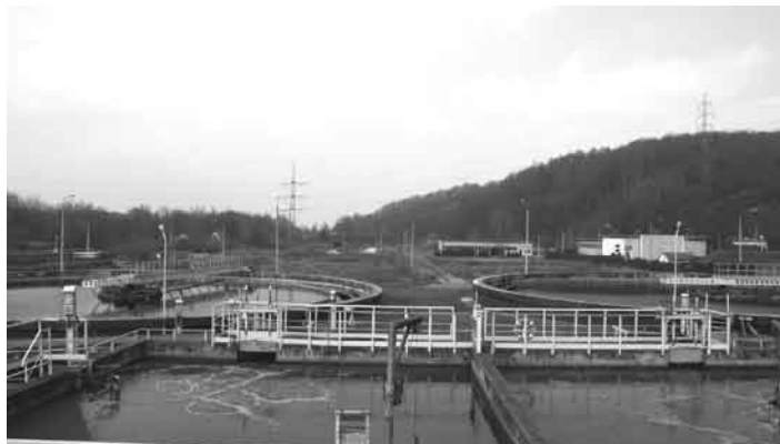
Oczyszczalnia ścieków - widok na zbiorniki
