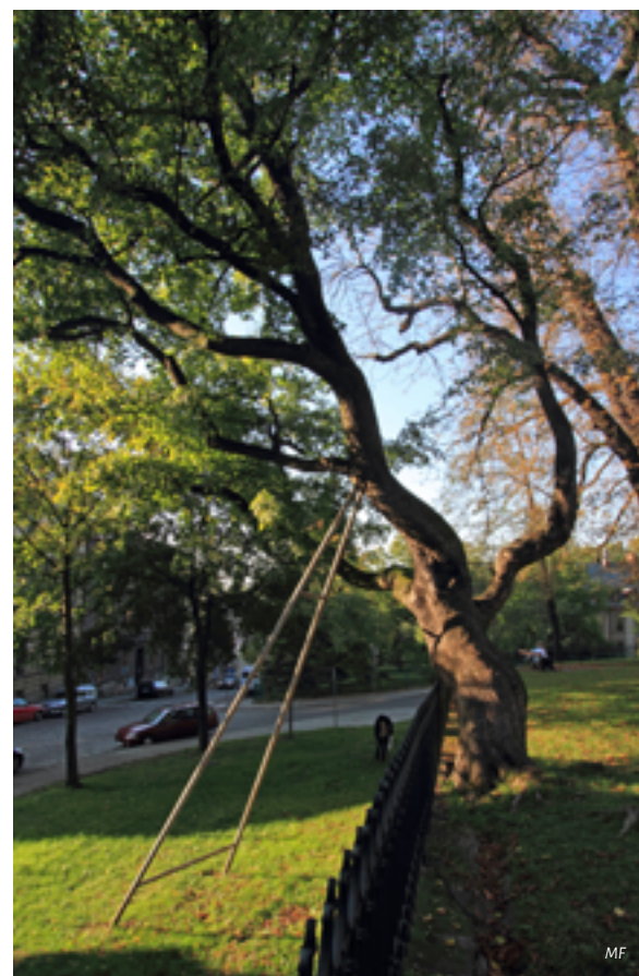
Stalowa podpora zabezpieczająca pomnikowy klon polny w parku Kościelnym
