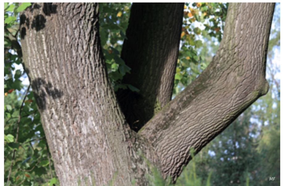
Oryginalny pokrój cieszyński tulipanowiec zawdzięcza rozgałęzieniu pnia na 3 główne przewodniki
