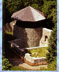
Rekonstrukcja wieży ostatecznej obrony, fot. 2004 r.
